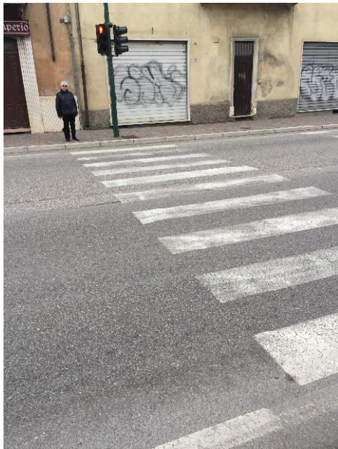
STATO ATTUALE Semaforo privo di segnalatore acustico
