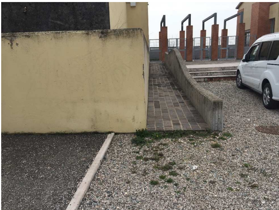
Figura 2 Stato Attuale. Presenza di pavimentazione a raso e di rampa con pendenza a norma.
