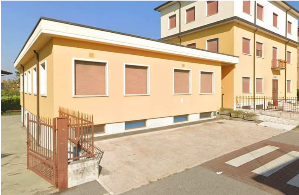
Figura 2_Stato Attuale. Rampa di accesso priva di pianerottolo di sosta
