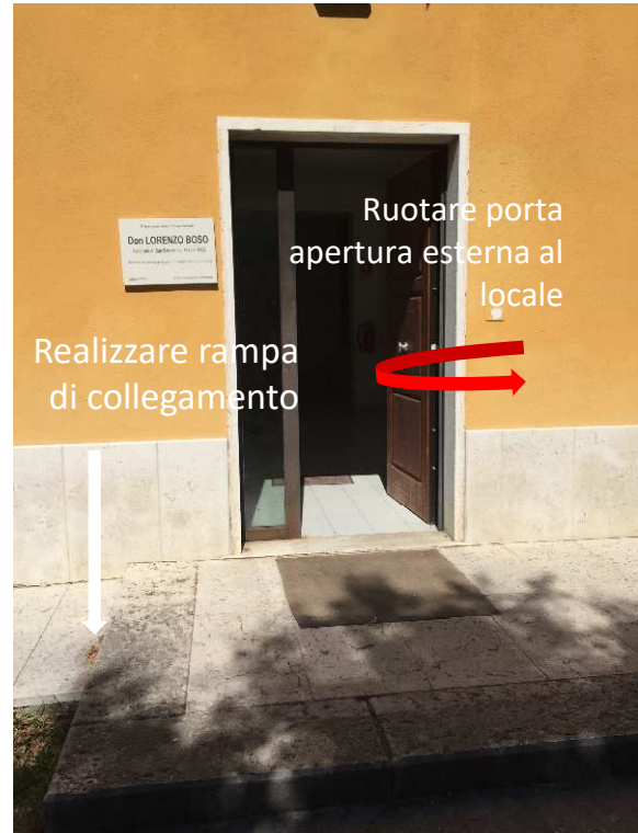
Figura 2_Stato Attuale. Presenza di gradini sul percorso per l'accesso all'edificio
