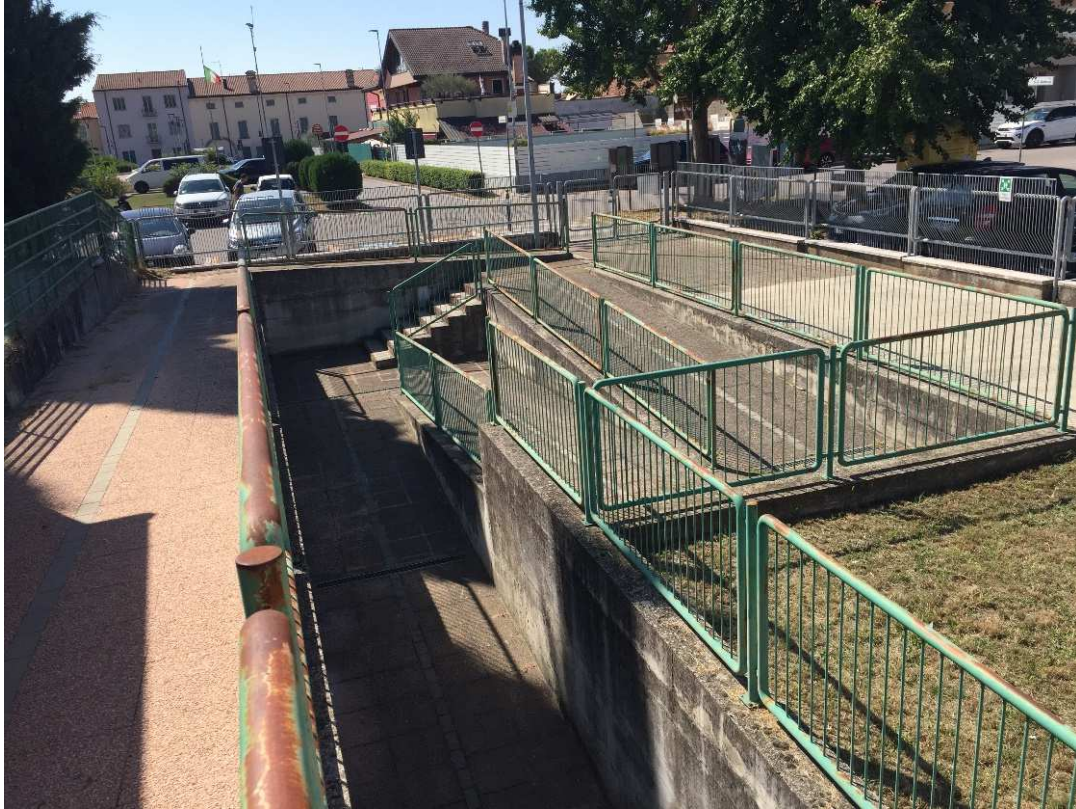
Figura 2_Stato Attuale. Sala civica accessibile. Rampa con pendenza a norma
