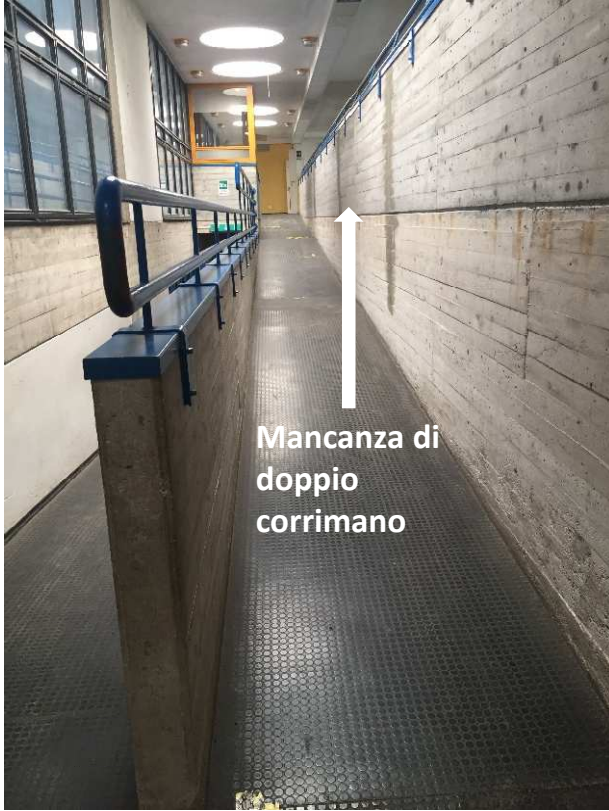
Figura 4_Stato Attuale. Rampa di accesso ai piani con pendenza a norma. Mancanza di doppio corrimano. Pavimentazione da sistemare.
