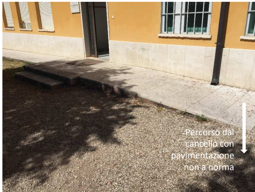
Figura 2_Stato Attuale. Presenza di gradini sul percorso per l'accesso all'edificio
