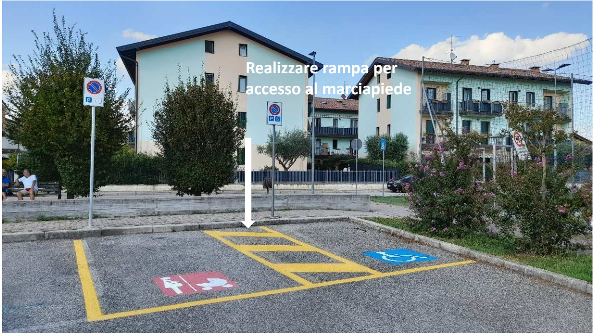
Figura 1_Stato Attuale. Parcheggio privo di rampa per accesso al marciapiede. Strisce pedonali prive di raccordo con rampa al marciapiede e accesso al centro sportivo privo di marciapiede
