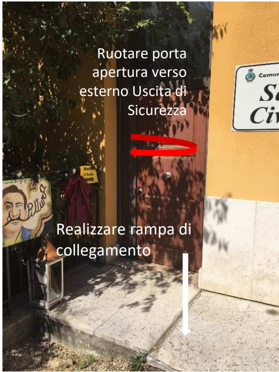
Figura 2_Stato Attuale. Presenza di gradini sul percorso per l'accesso all'edificio
