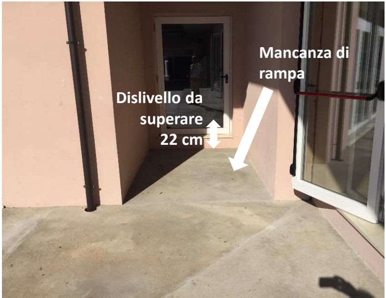
Figura 6_Stato Attuale. Cortile non accessibile. Mancanza di rampe di uscita dall'edificio verso il cortile
