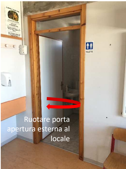
Figura 3_Stato attuale Servizi igienici a norma piano terra e piano palestra. Si consiglia di realizzare un servizio igienico a norma anche al piano primo (girando la porta), accessibile dal piano mezzanino. Dimensioni locale 185x170 cm
