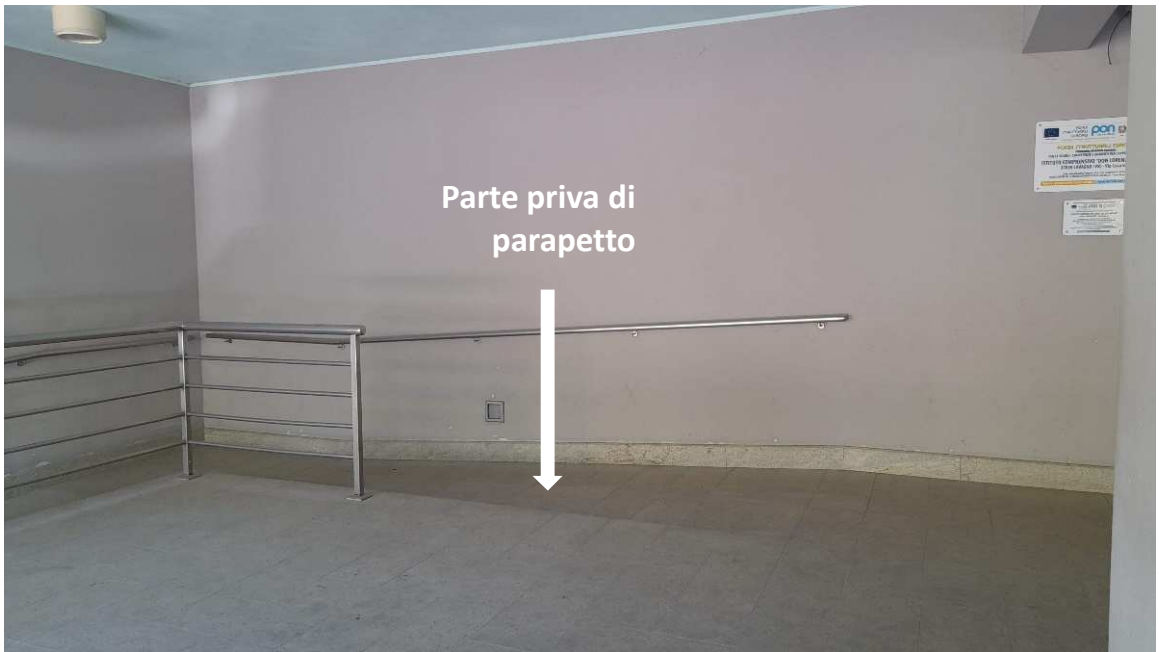
Figura 2_Stato Attuale. Rampa per accesso scuola a norma Ultima parte priva di parapetto. Mancanza di doppio corrimano
