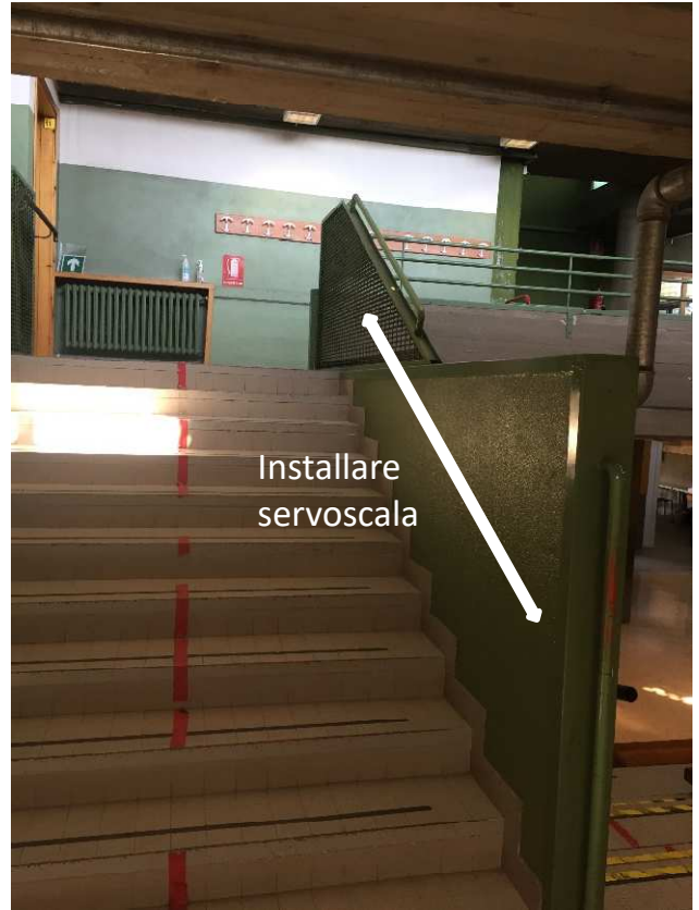
Figura 4_ Stato attuale Installare vano scala tra piano terra e rialzato e tra piano rialzato e mezzanino. Mettere in funzione servoscala di collegamento con il piano terra palestra.
