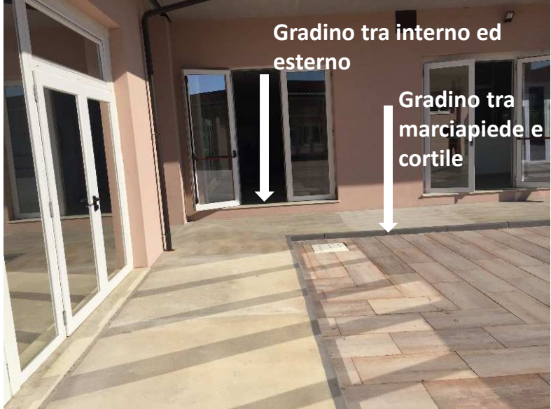
Figura 6_Stato Attuale. Cortile non accessibile. Mancanza di rampe di uscita dall'edificio verso il cortile
