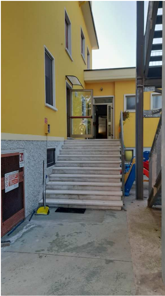
Figura 6_Stato attuale Cortile sul retro non raggiungibile. Mancanza di rampa di collegamento
