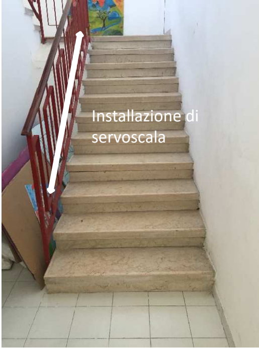
Figura 3_Stato attuale Mancanza di collegamenti verticali ai piani. Si consiglia installazione di servoscala.
