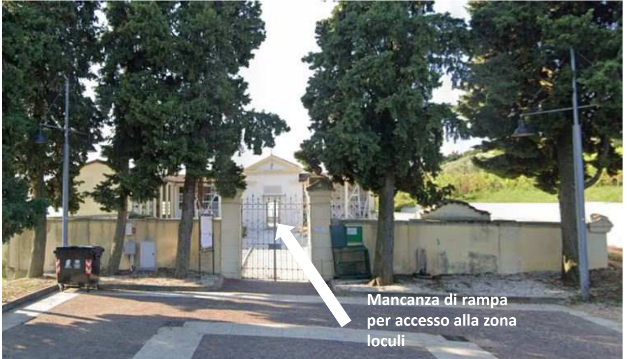
Figura 2_Stato Attuale. Mancanza di rampa per accedere alla zona loculi coperta
