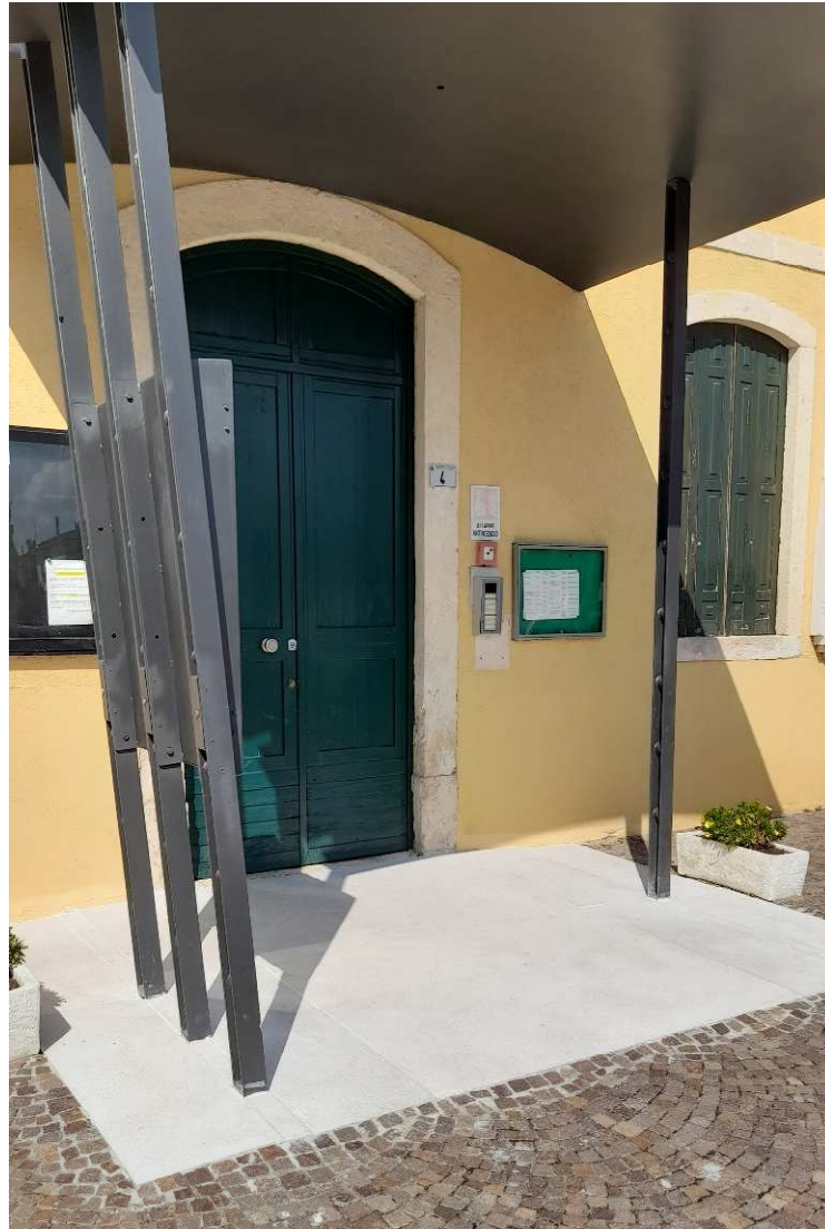
Figura 1_Stato Attuale. Ingresso a raso nella parte centrale , porta a battente. Spazi antistante e retrostante la porta ingresso L>150 cm. Presente impianto citofonico e campanello.
