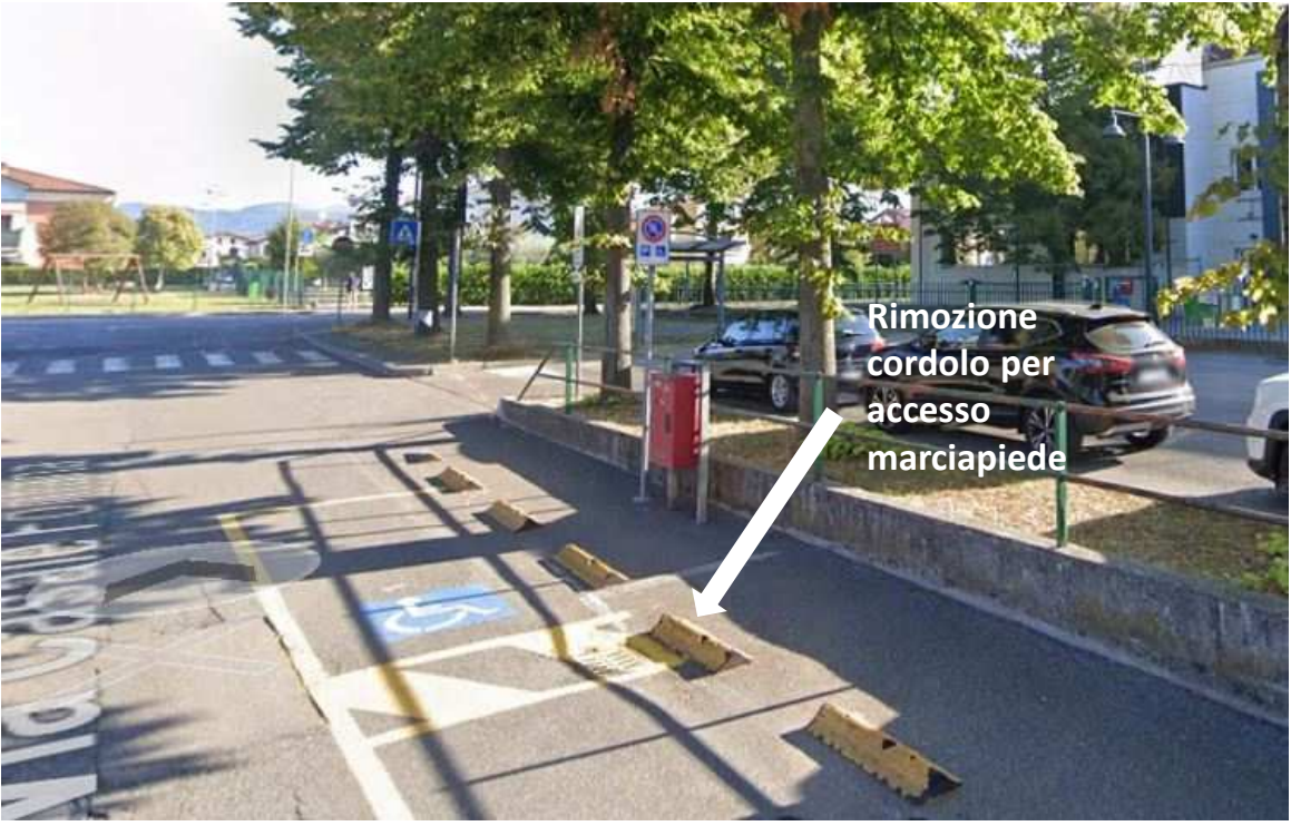
Figura 1_Stato Attuale. Demolizione cordolo per accesso al marciapiede
