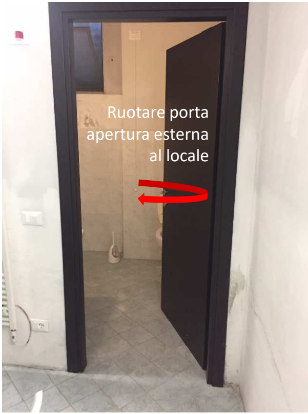
Figura 3_Stato attuale Servizio igienico dimensioni 190x200. Porta ingresso 80 cm da girare (apertura verso l'esterno), per consentire gli spazi di manovra per l'accesso. Dimensioni adeguate per l'affiancamento alla tazza e distanza frontale lavabo. Manca campanello di allarme.
