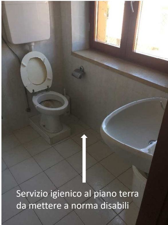
Figura 3_Stato attuale Servizi igienici non a norma piano terra e piano primo.
