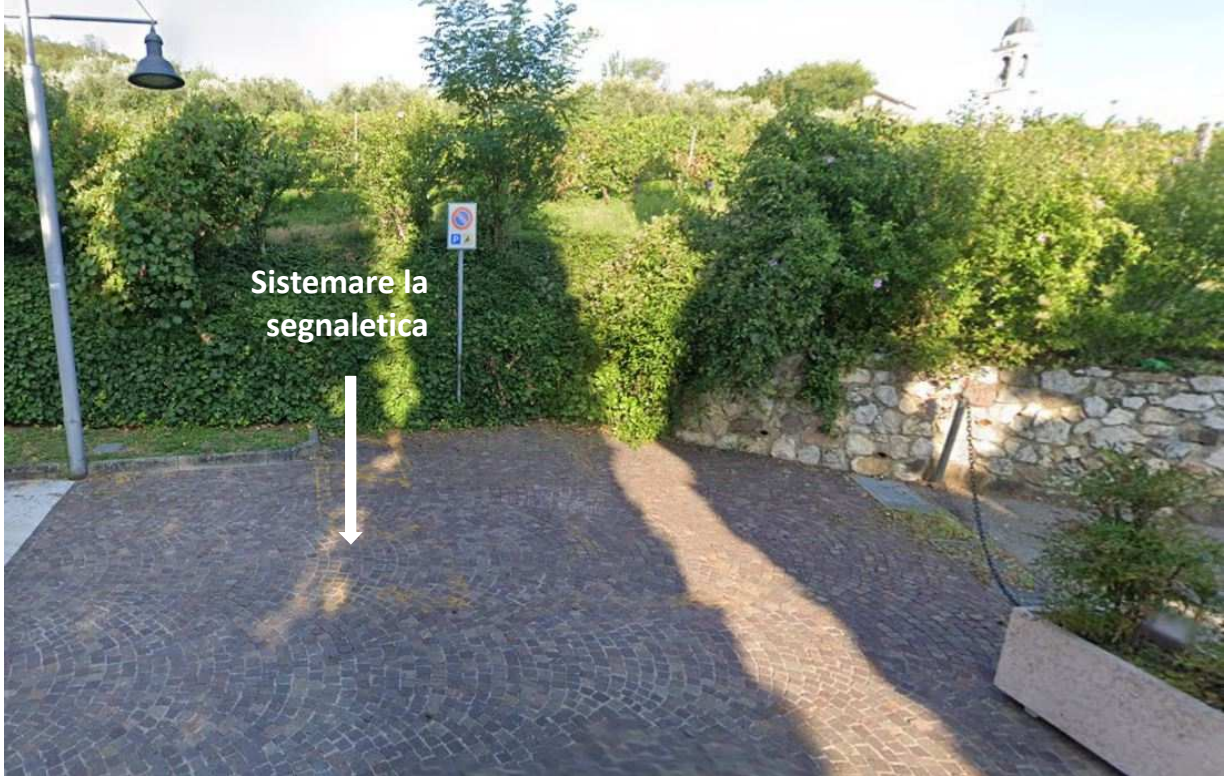
Figura 1_Stato Attuale. Parcheggio con segnaletica a norma
