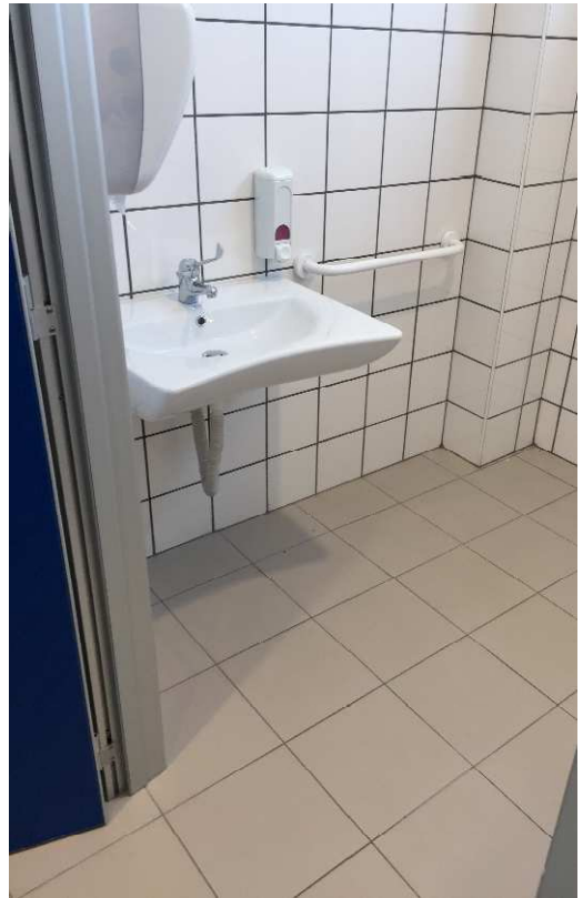
Figura 3_ Stato attuale Servizi igienici accessibili piano terra e piano primo. Dimensioni adeguate e distanza dai sanitari a norma per consentire l'affiancamento alla tazza wc. Manca campanello di allarme e avvisatore ottico acustico.
