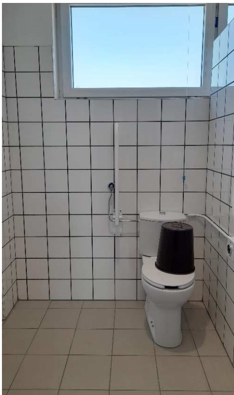
Figura 3_ Stato attuale Servizi igienici accessibili piano terra e piano primo. Dimensioni adeguate e distanza dai sanitari a norma per consentire l'affiancamento alla tazza wc. Manca campanello di allarme e avvisatore ottico acustico.
