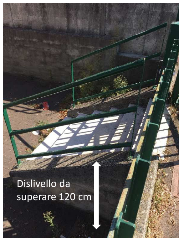
Figura 2_Stato Attuale. Edificio non accessibile . L'ingresso della scuola musica si trova a quota -120 cm rispetto al marciapiede. Edificio privo di rampe e servoscala
