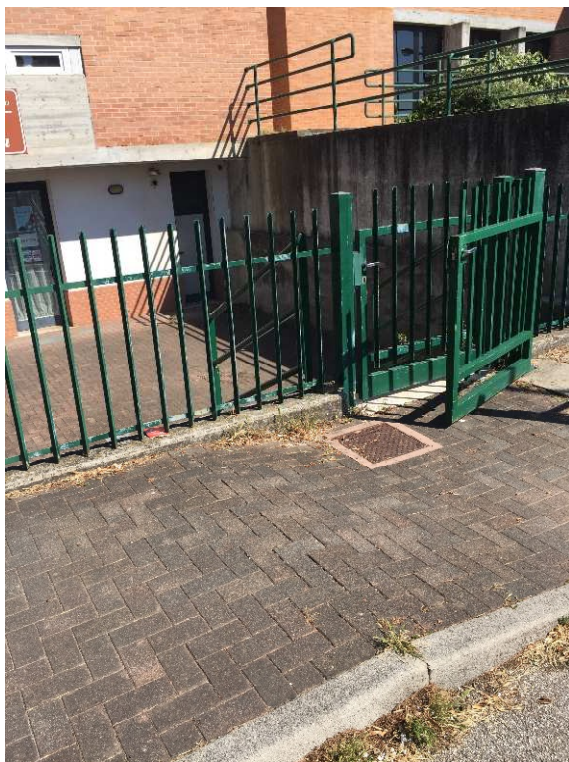
Figura 2_Stato Attuale. Edificio non accessibile . L'ingresso della scuola musica si trova a quota -120 cm rispetto al marciapiede. Edificio privo di rampe e servoscala
