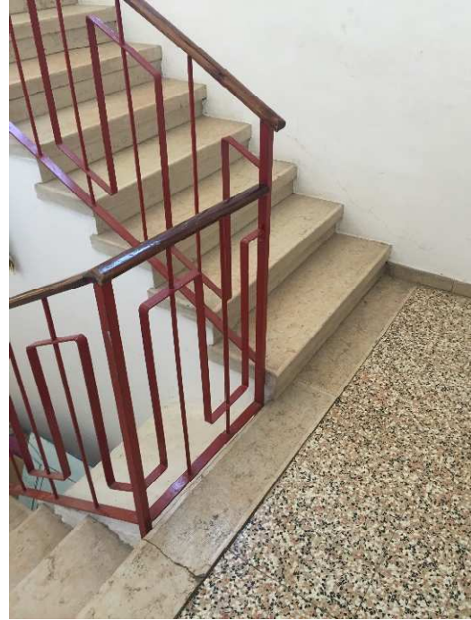
Figura 3_Stato attuale Mancanza di collegamenti verticali ai piani. Si consiglia installazione di servoscala.
