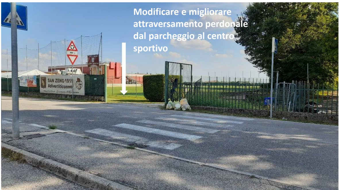
Figura 1_Stato Attuale. Parcheggio privo di rampa per accesso al marciapiede. Strisce pedonali prive di raccordo con rampa al marciapiede e accesso al centro sportivo privo di marciapiede
