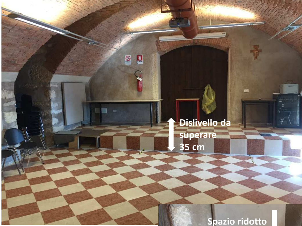
Figura 4_Stato Attuale Palco non accessibile. Presenza di rampa con pendenza >8%. Dislivello da superare 35 cm
