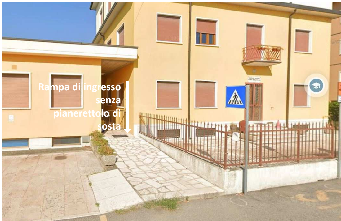
Figura 2_Stato Attuale. Rampa di accesso priva di pianerottolo di sosta
