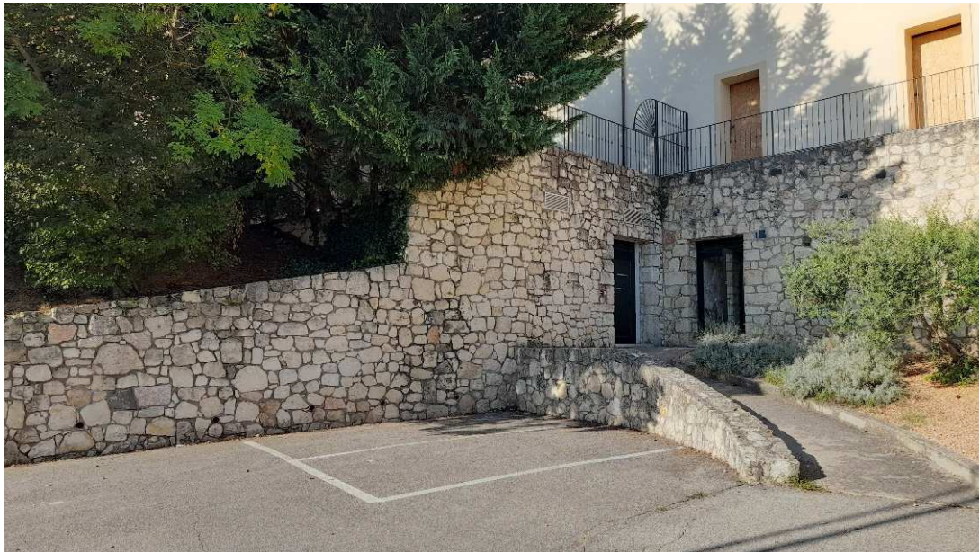
Figura 1_Stato Attuale. Mancanza di parcheggio riservato con segnaletica a norma.
