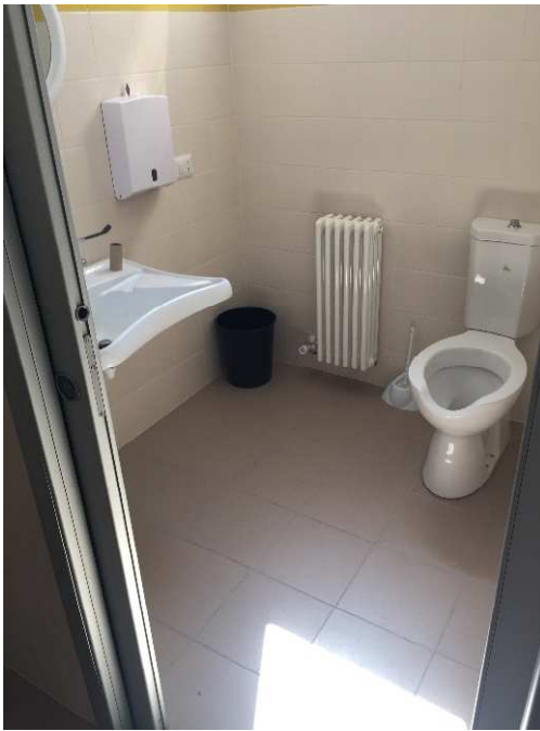
Figura 3_Stato attuale Servizi igienici a norma piano terra e piano palestra. Si consiglia di realizzare un servizio igienico a norma anche al piano primo (girando la porta), accessibile dal piano mezzanino. Dimensioni locale 185x170 cm
