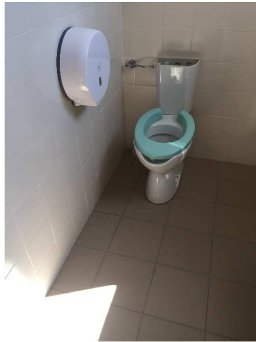
Figura 3_Stato attuale Servizi igienici a norma piano terra e piano palestra. Si consiglia di realizzare un servizio igienico a norma anche al piano primo (girando la porta), accessibile dal piano mezzanino. Dimensioni locale 185x170 cm
