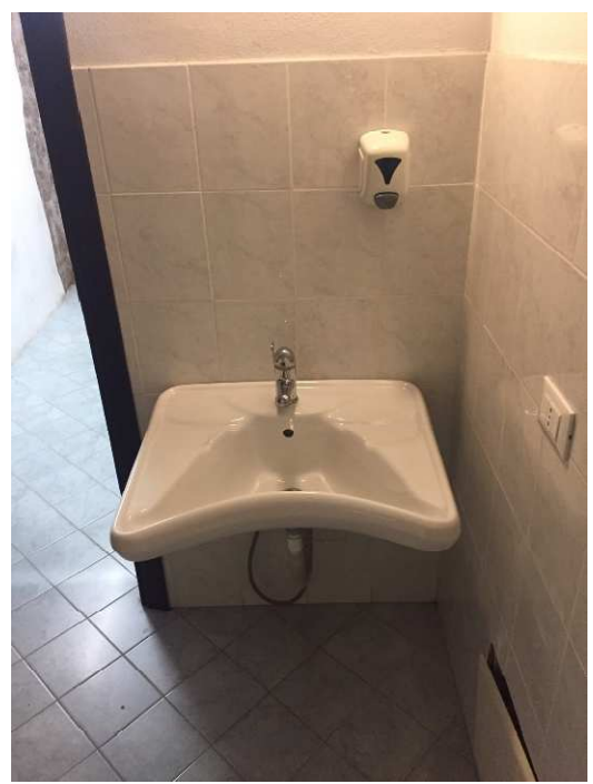
Figura 3_Stato attuale Servizio igienico dimensioni 190x200. Porta ingresso 80 cm da girare (apertura verso l'esterno), per consentire gli spazi di manovra per l'accesso. Dimensioni adeguate per l'affiancamento alla tazza e distanza frontale lavabo. Manca campanello di allarme.
