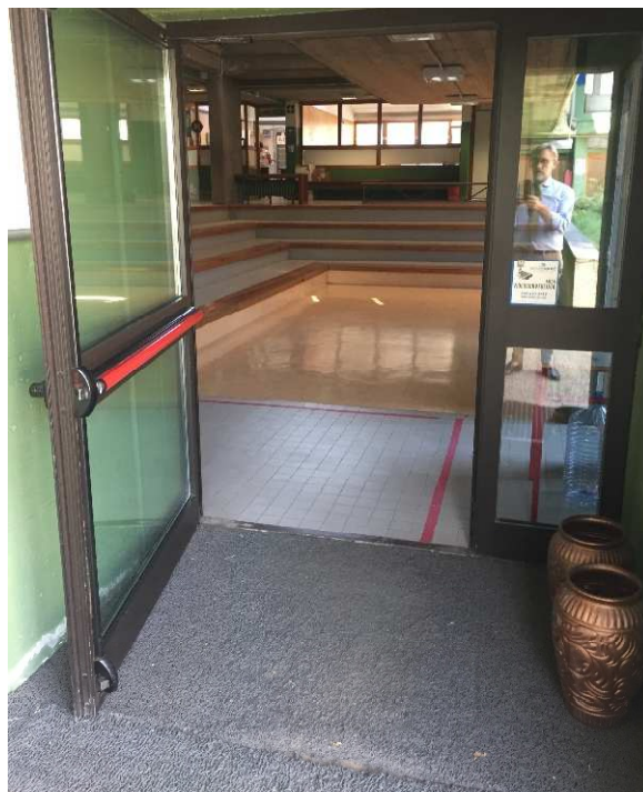
Figura 2 Stato Attuale. Percorso in quota. Spazi antistante e retrostante la porta ingresso L>150 cm per consentire arretramento e manovre.
