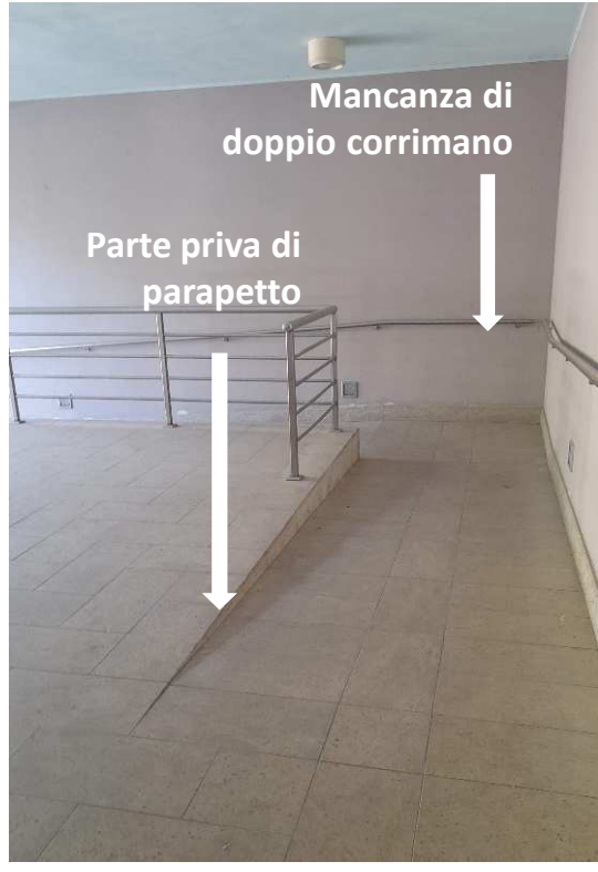
Figura 2_Stato Attuale. Rampa per accesso scuola a norma Ultima parte priva di parapetto. Mancanza di doppio corrimano
