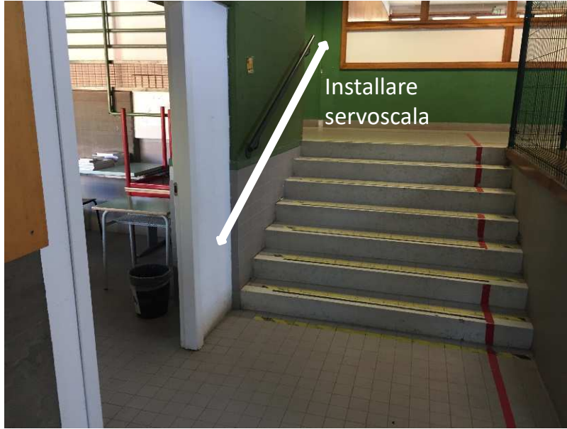
Figura 4_ Stato attuale Installare vano scala tra piano terra e rialzato e tra piano rialzato e mezzanino. Mettere in funzione servoscala di collegamento con il piano terra palestra.
