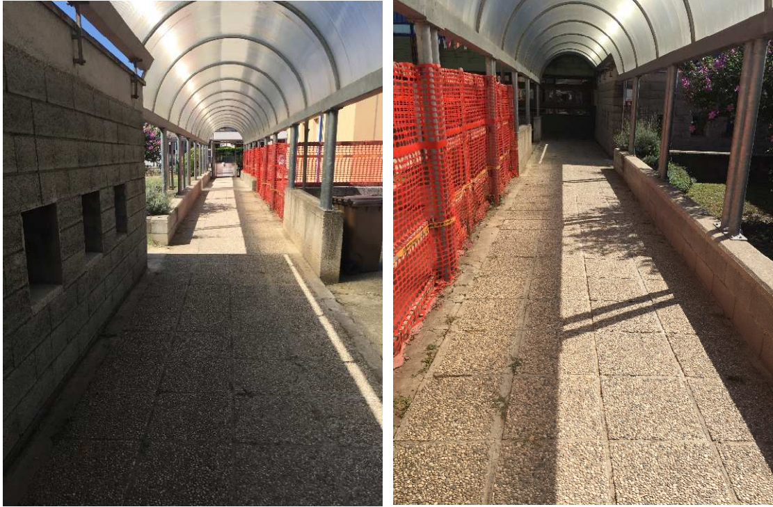
Figura 2 Stato Attuale. Percorso in quota. Spazi antistante e retrostante la porta ingresso L>150 cm per consentire arretramento e manovre.
