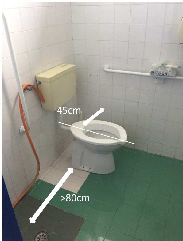
Figura 3_Stato attuale Servizio igienico accessibile piano terra. Dimensioni 180x180 cm. Porta ingresso bagno larghezza 90 cm. Porta ingresso antibagno da invertire (apertura verso il corridoio), per consentire gli spazi di manovra. Distanza per l'affiancamento alla tazza adeguata. Manca campanello di allarme e avvisatore ottico acustico.
