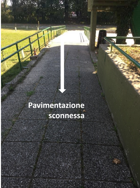
Figura 6_Stato Attuale. Rampa per accesso al cortile con pavimentazione sconnessa
